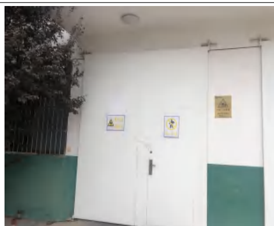
一般固废暂存间
