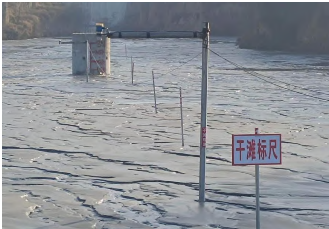
在线干滩起测点调整前照片
