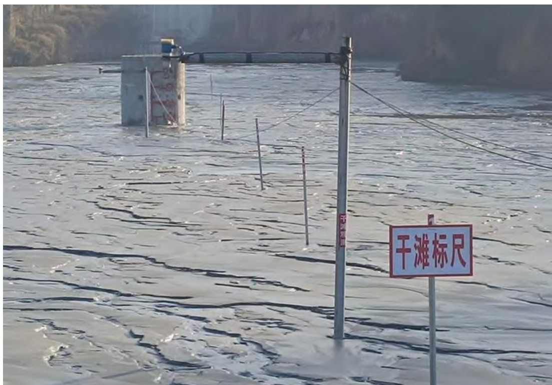
排水井水位观测标尺整改前
