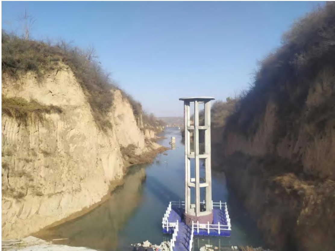
浮桥整改后照片
