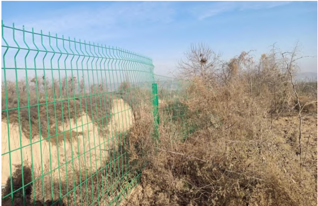
右侧岸坡防护网整改后照片
