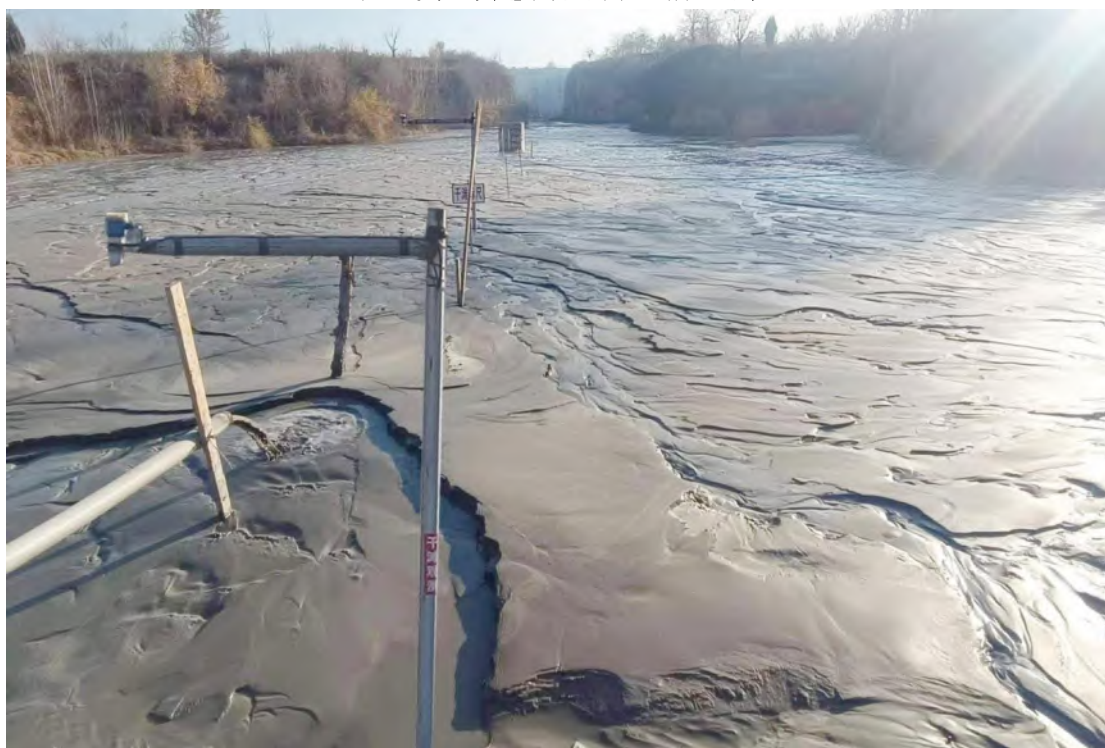
在线干滩起测点调整后照片
