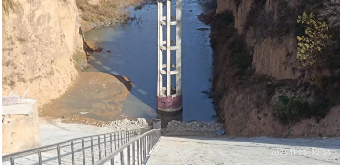
浮桥整改前照片
