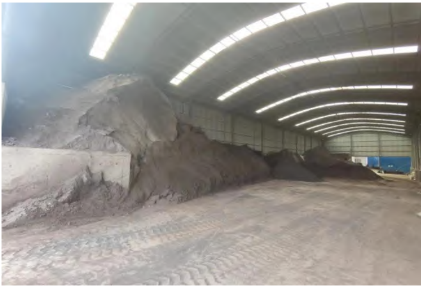
原料堆场内部
