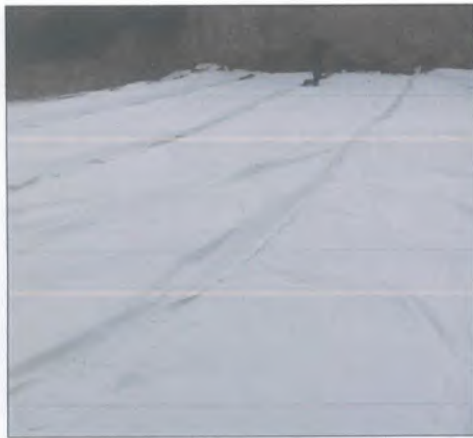
项目防渗膜铺设中照片
