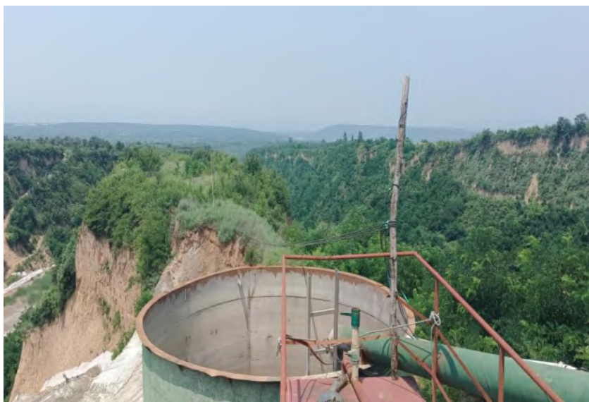
尾矿库回水池
