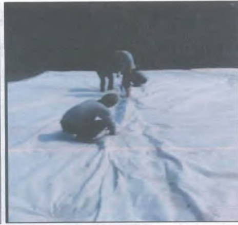
项目防渗膜焊接中照片
