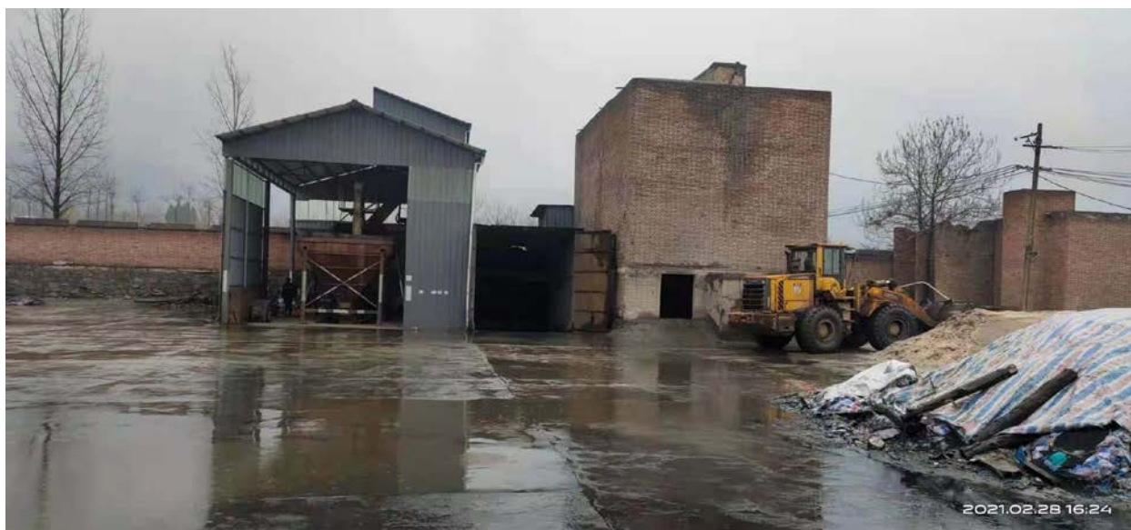
项目厂区现状
